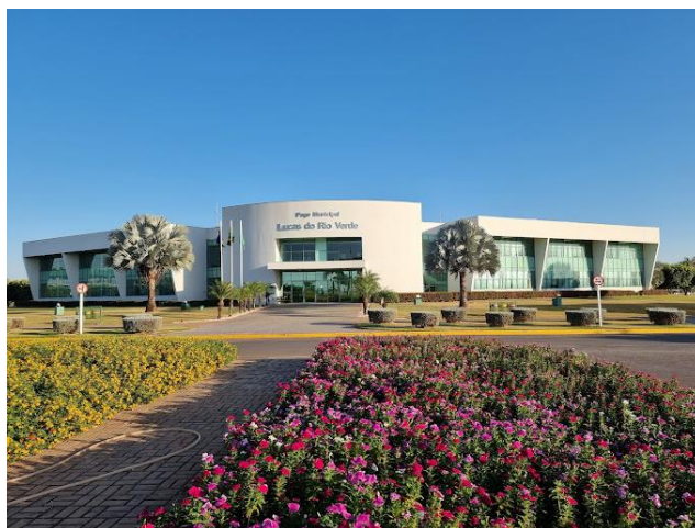
Figura 1 - Fachada do paço municipal, sede da secretaria municipal de educação, 15/07/2023
