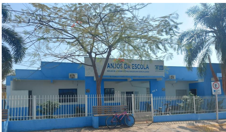
Figura 30 – Foto fachada Anjos da Escola
