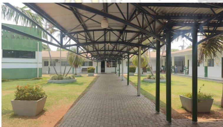
Figura 6 – Foto passarela interior Escola Fredolino Vieira Barros
