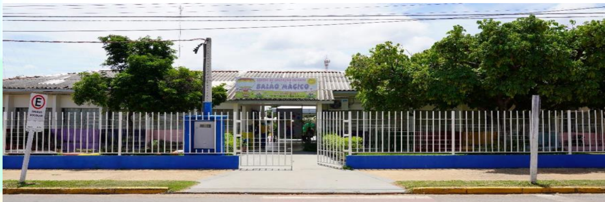
Figura 21 – Foto fachada CEI Balão Mágico
