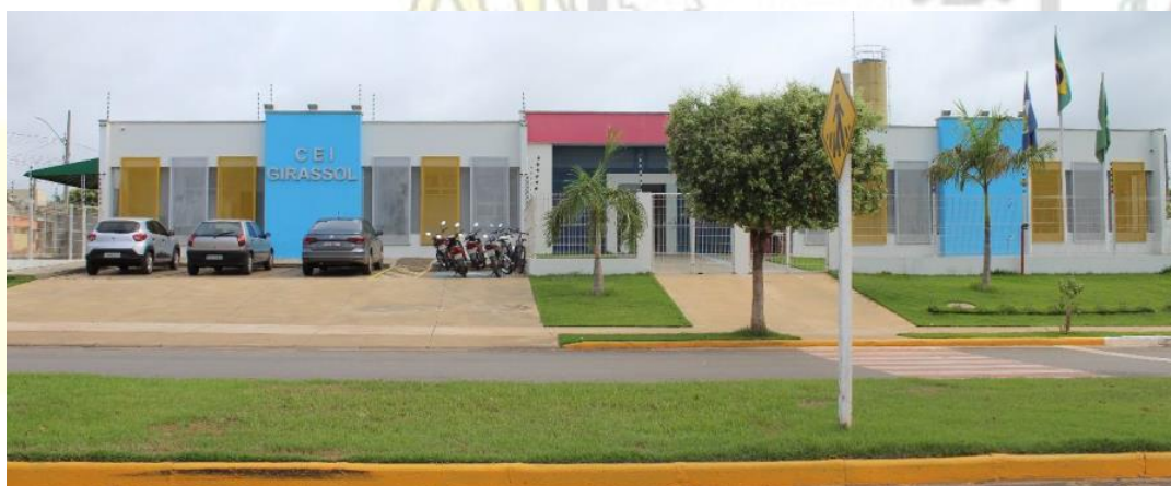
Figura 20 – Foto fachada CEI Girassol
