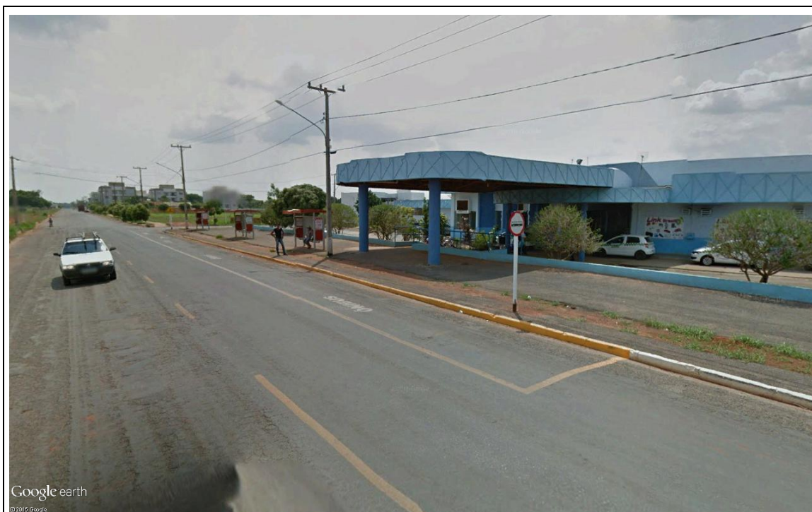
Figura 39 – Terminal de Integração (Terminal Rodoviário)
