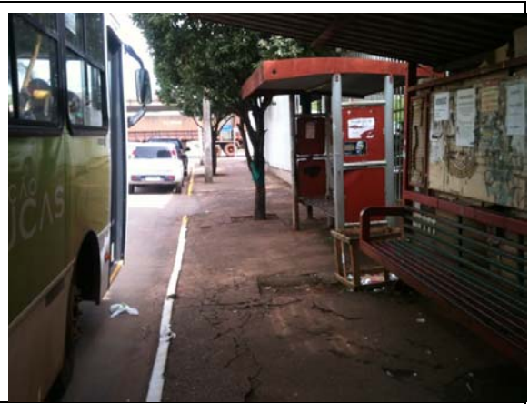
Av. Mato Grosso próximo à Av. Amazonas
