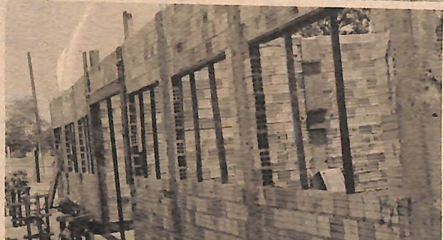
Construção da Escola municipal Bernardo Guimarães e ampliação da Escola Municipal Eça de Queirós.
