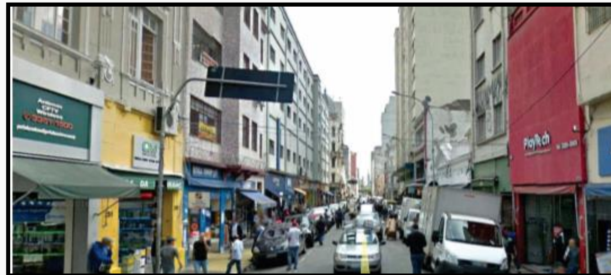
Rua Santa Efigênia com edifícios colados sem ventilação e sem iluminação natural em São Paulo.
