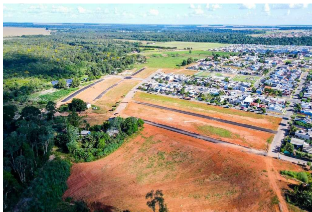
Programa Habitacional: Sonho Meu—etapa 1 Unidades: 107 Ano: 2022 Situação: em andamento
