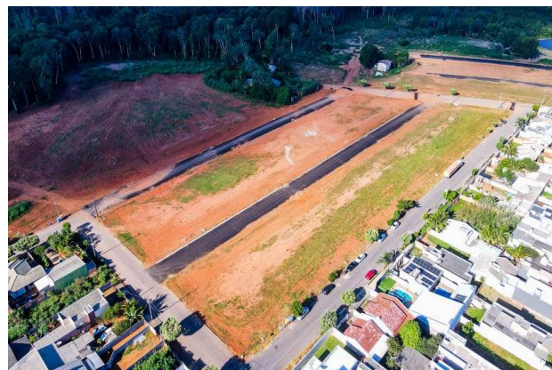
Programa Habitacional: Sonho Meu—etapa 1 Unidades: 180 Ano: 2023 Situação: em andamento
